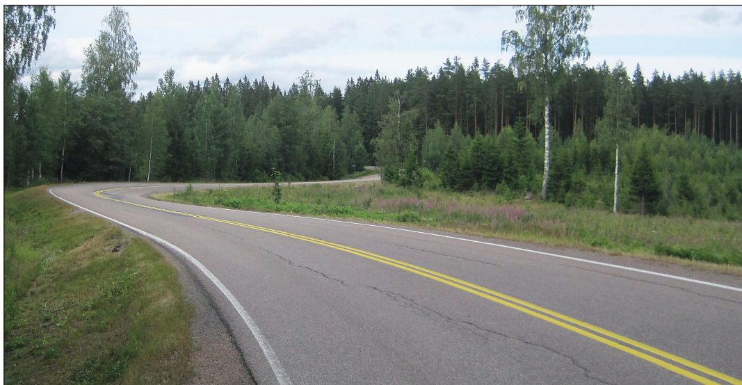
Turvallinen tie. Asfaltti kuivaa ja ehjää. Näkyvyyttä riittää. Mutkan voi ajaa vauhdilla.
